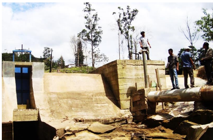
Gambar 1. Bendungan, bak penenang dan pipa pesat.
