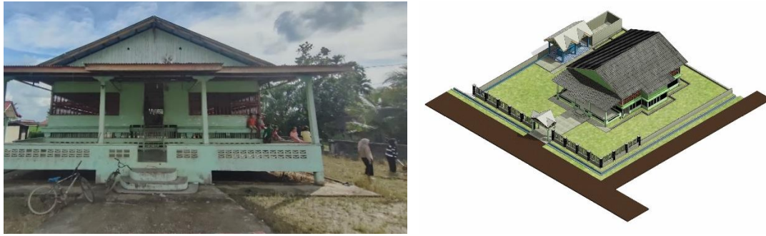
Gambar 1 Kondisi Eksisting bangunan meunasah
