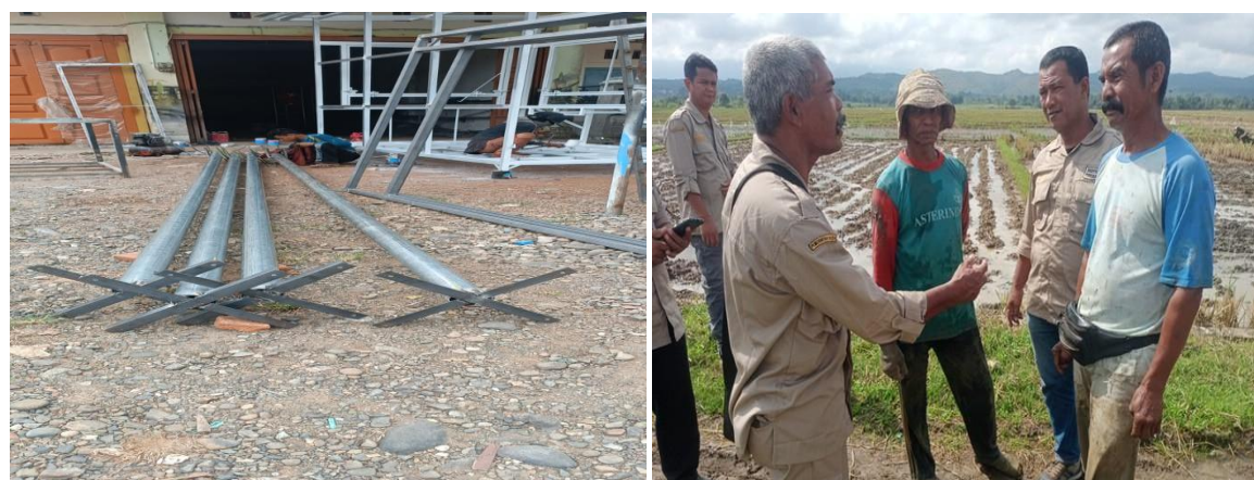
Gambar 2. Pesiapan Bahan dan Alat, Pembuatan Struktur Rumah Burung Hantu dan Pemasangan di Persawahan Petani
