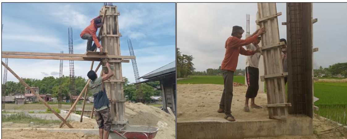
Gambar 4. Pelaksanaan pekerjaan pengocoran tiang beton penyangga lantai dua balai pengajian
