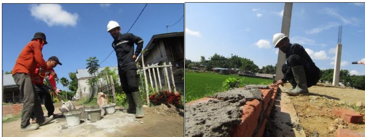
Gambar 5. Pekerjaan persiapan pembuatan batu nol untuk pengecoran lantai dasar balai pengajian
