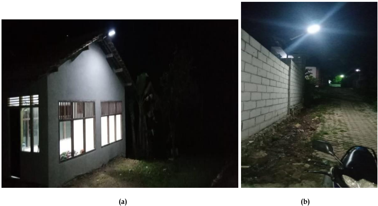
Gambar 6. Lampu penerangan system tenaga surya beroperasi saat malam hari di Desa Nunyai Raja Basa pada September 2022. (a) lokasi Mushola Desa, (b) Jalan di Desa Nunyai Raja Basa.
