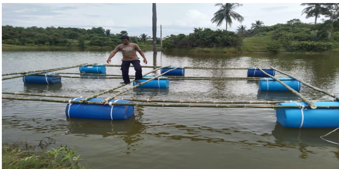
Gambar 6. Desain Instalasi Etelah Jadi Pada Embung
