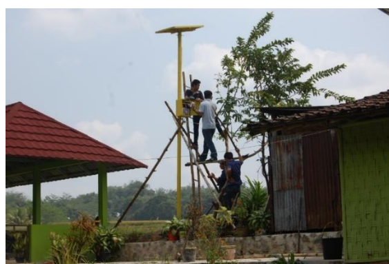
Gambar 8 Menginstall PLTS setelah ditegakkan
