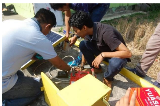
Gambar 6 Instalasi plts sebelum dipasang
