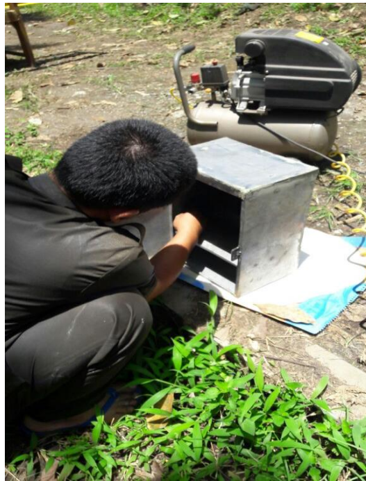
Gambar 3. Pengecatan tempat baterai
