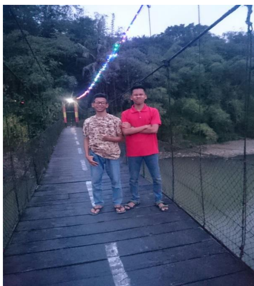
Gambar 10 Hasil pemasangan PLTS
