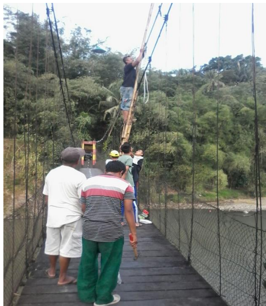
Gambar 9 Pemasangan instalasi pada jembatan gantung
